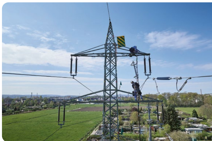
Am SINTEG-Vorhaben „Designnetz: Baukasten Energiewende“ nahmen Stadtwerke und Netzbetreiber aus Nordrhein-Westfalen teil.
