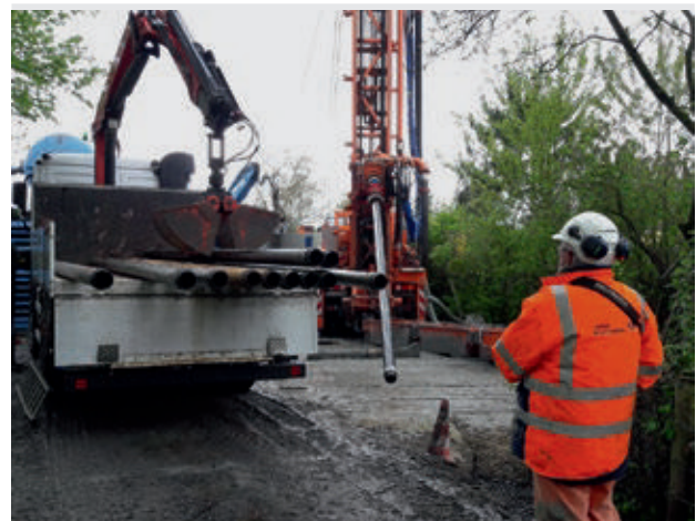
Bild 6.2 – Bohr- und Einbauarbeiten einer Kabelanoden-Anlage (Quelle: B. Schröter, Bezirksregierung Arnsberg)
