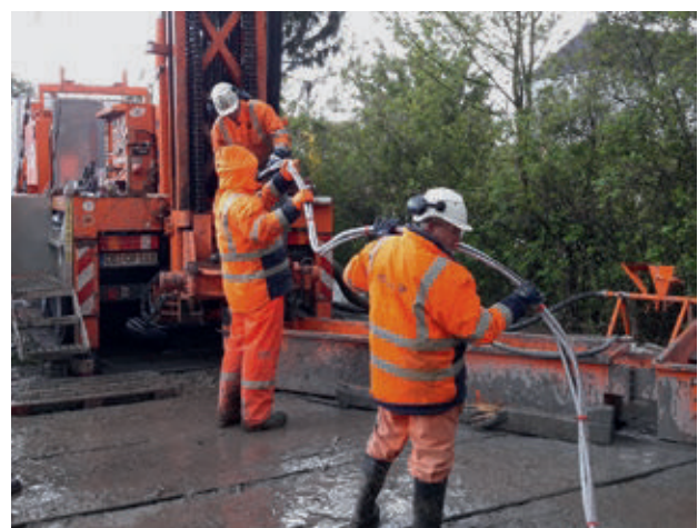
Bild 6.3 – Einbauarbeiten einer Kabelanoden-Leitung (Quelle: B. Schröter, Bezirksregierung Arnsberg)
