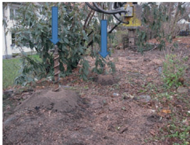
Bild 12.4 – Gestänge zur Herstellung von zwei Kampfmittelsuchbohrungen
